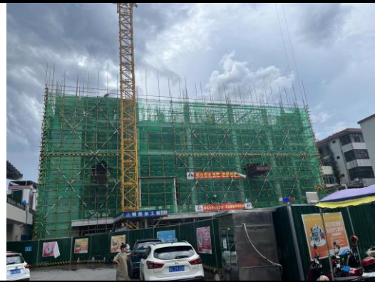
图 2-13 公共卫生大楼（在建）
